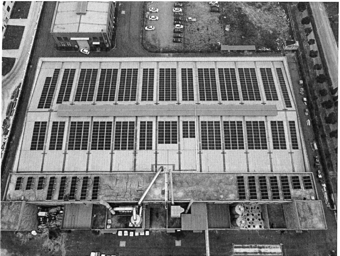
建设的屋顶光伏
